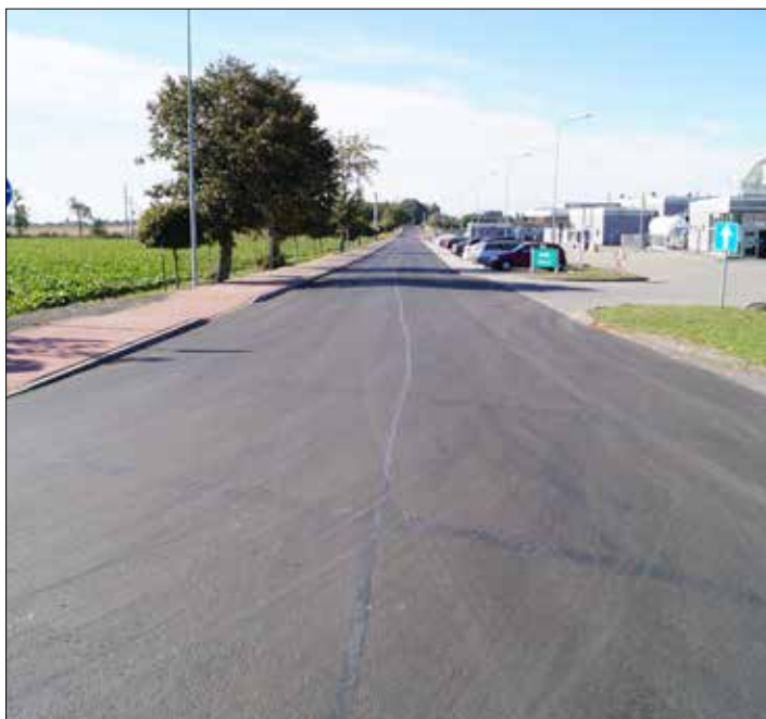
ul. Południowa po modernizacji
